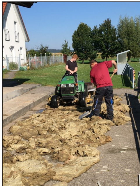
Von der Isolierung muss das Wasser raus. Sie muss teuer als Sondermüll abgewogen und entsorgt werden.
